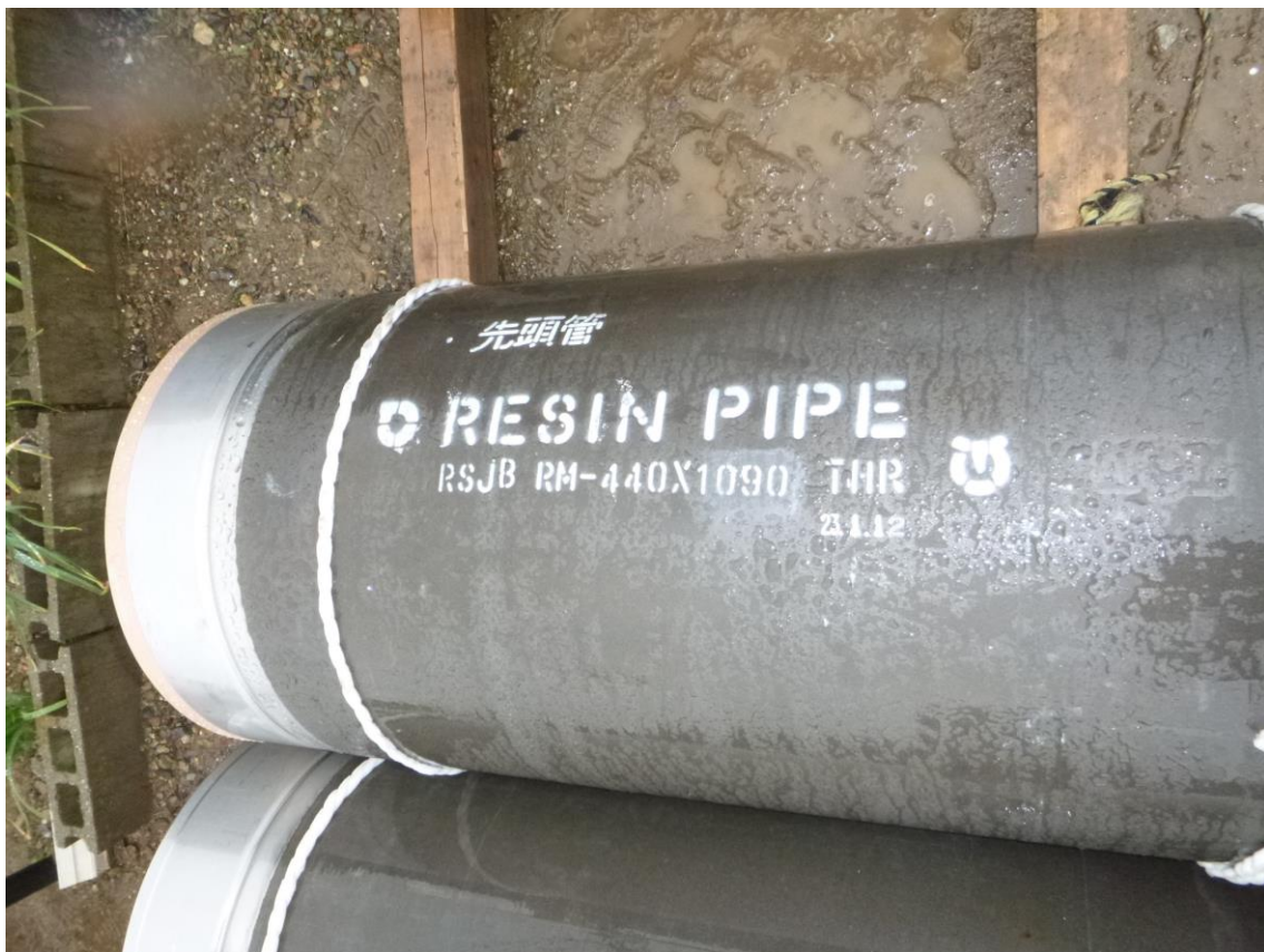
桑名（桑西幹線污水管路施設工事）
