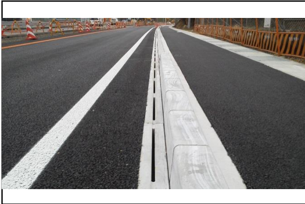
248 号線側溝 NRC 形
