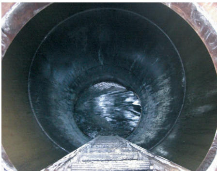
通過マンホール
