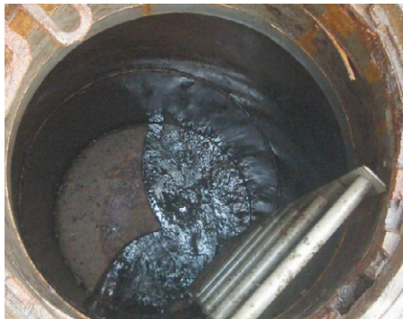
合流マンホール
