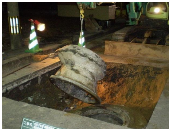
写真3－3 斜壁の撤去
