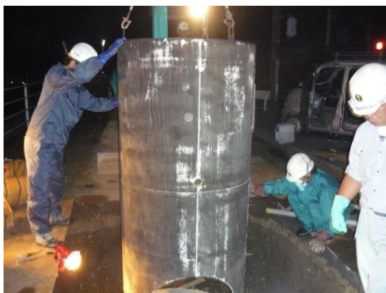
写真 3－10 直壁設置状況
