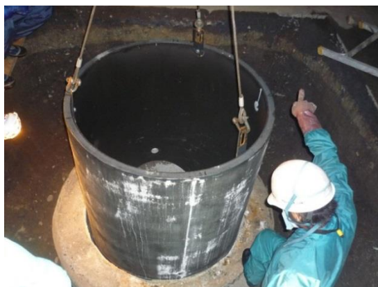
写真 3－10 直壁設置状況
