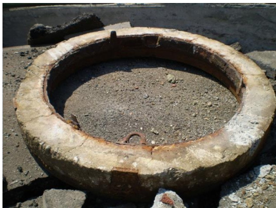
写真3－2 蓋および受け枠の撤去
