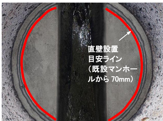
写真 3－11 エポキシ充てん接着剤塗布 （直壁設置前）P. 18 参照
